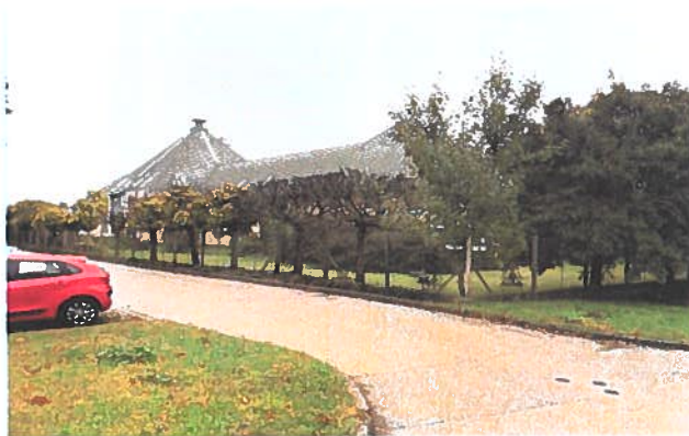
intézmény a Hangya sor túlsó oldalán
