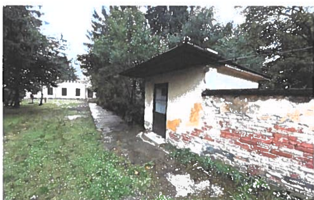
bejárat Sajnovics tér (ÉNY), portásfülke
