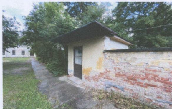
bejárat Sajnovics tér (ÉNY), portásfülke
