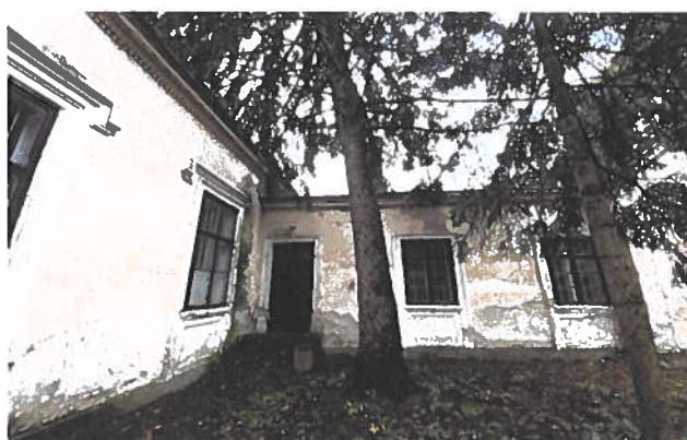
épület felé dőlő fenyőfák
