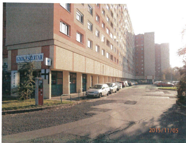
Panel épület a Lajos utca - Tél utca sarkán
