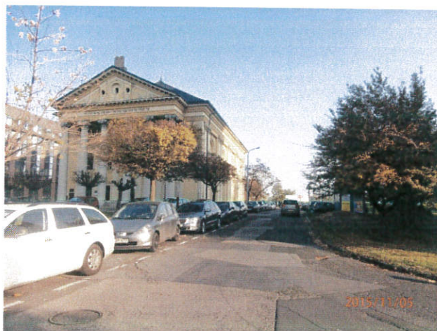
Tél utca, zsinagóga északnyugati homlokzata
