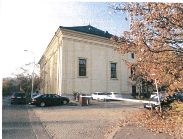
Zsinagóga délkeleti homlokzata, az Aquincum Hotel sorompóval lezárt parkolója
