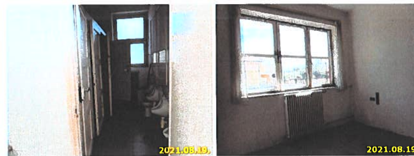
Férfi WC, földszinti terem
