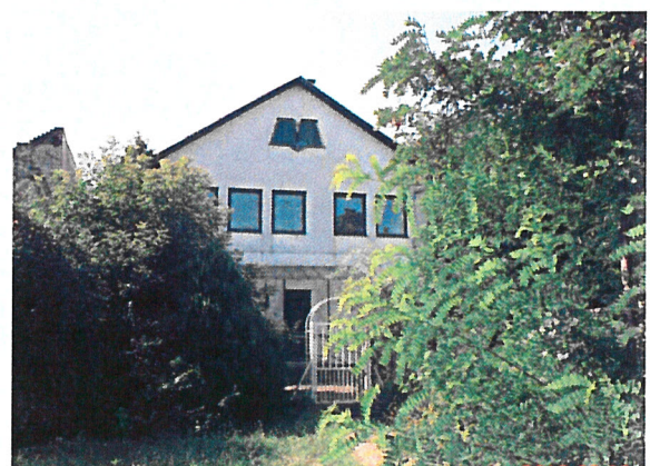
kert felőli homlokzat
