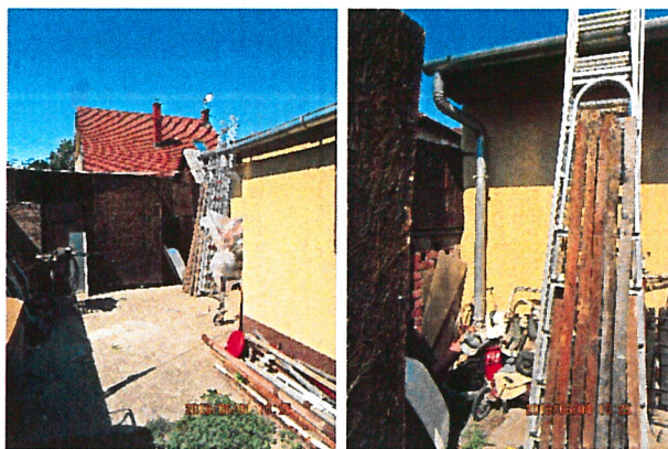
Térképmásolaton is szereplő téglamelléképület
