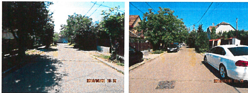
A telek Bácska utca felőli megközelítése, utcakép
