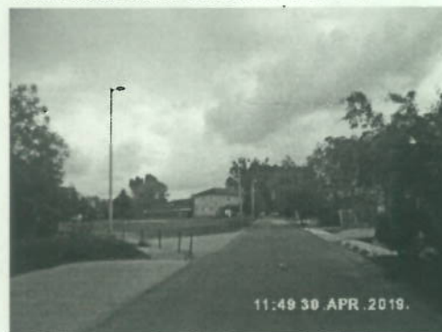
A Sisakos sáska u. kiépített szakasza
