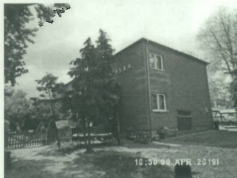
A 127592/10 hrsz.-on lévő, nem értékelt, bontandó óvoda felépítmény
