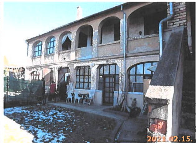
Oldalkert felőli homlokzat
