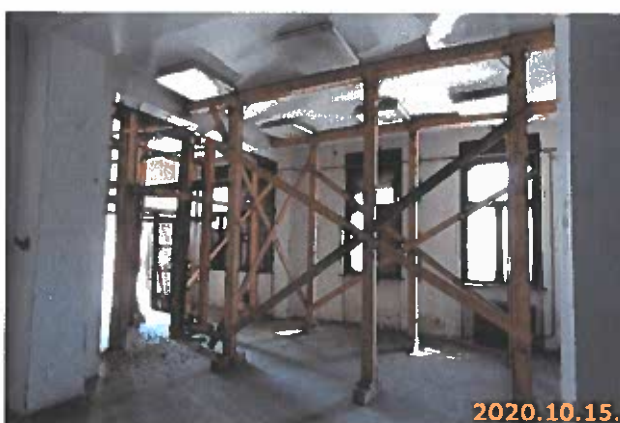
belső tér, aládúcolt födém
