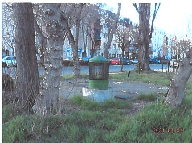
Földalatti építmény szellőzése
