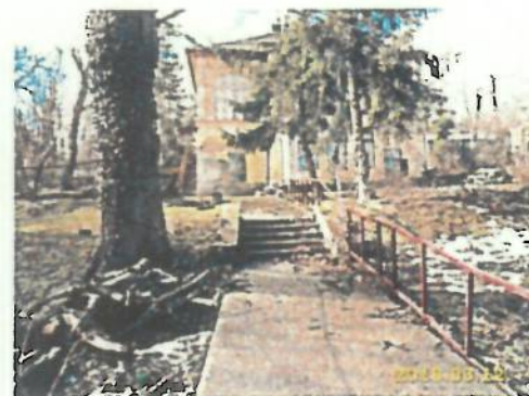
A főépület a felvezető úttal, észak felől
