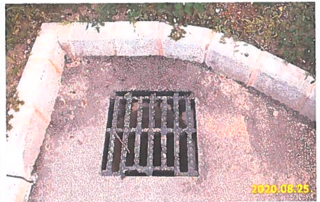
Csatorna fedlap és csapadékelvezetés az utcán
