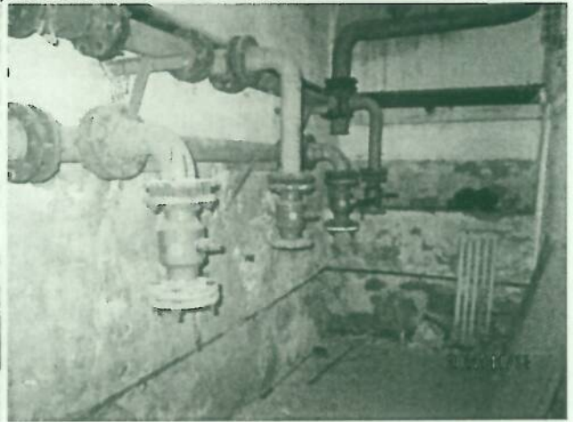
Pincszint, gázmérő helyiség, gázóra leszerelve
