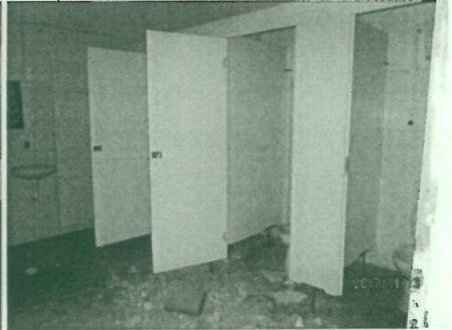
Földszint, férfi WC
