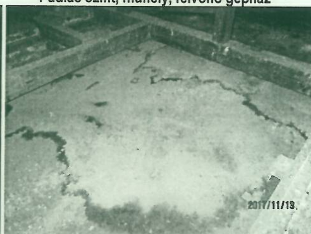
Padlástér, beázás nyoma
