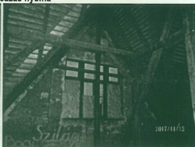
Padlástér, beázás nyoma
