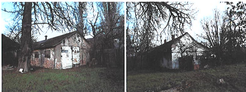
Téglasszerkezetű raktár, lakóház és gazdasági épület NY-i bejárata
