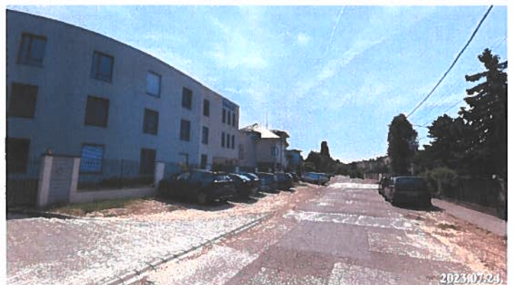
Délkelet felől szomszédos ingatlan 39691/231 hrsz.
