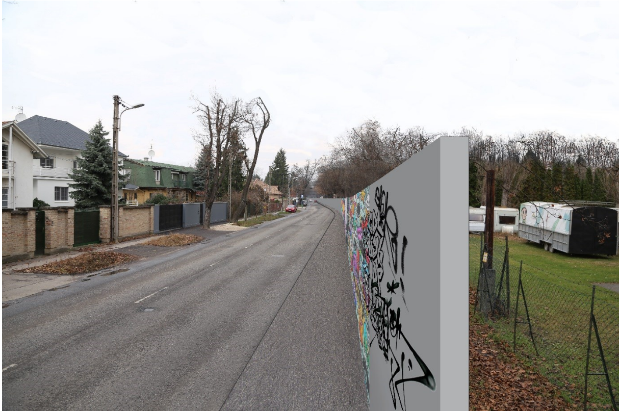
7. 5. fejezet 1. kép Beton árvízvédelmi fal a Nánási út – Királyok útján
