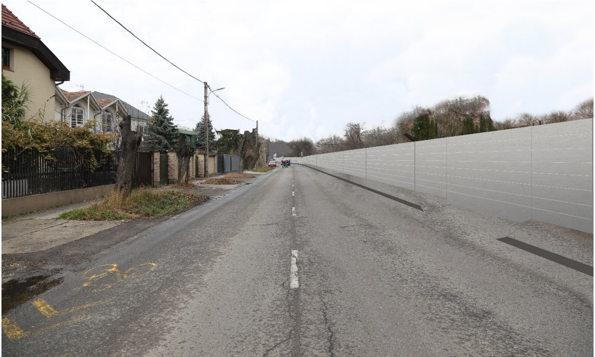
7. 5. fejezet 4. kép Felállított mobil árvízvédelmi fal a Nánási út – Királyok útján
