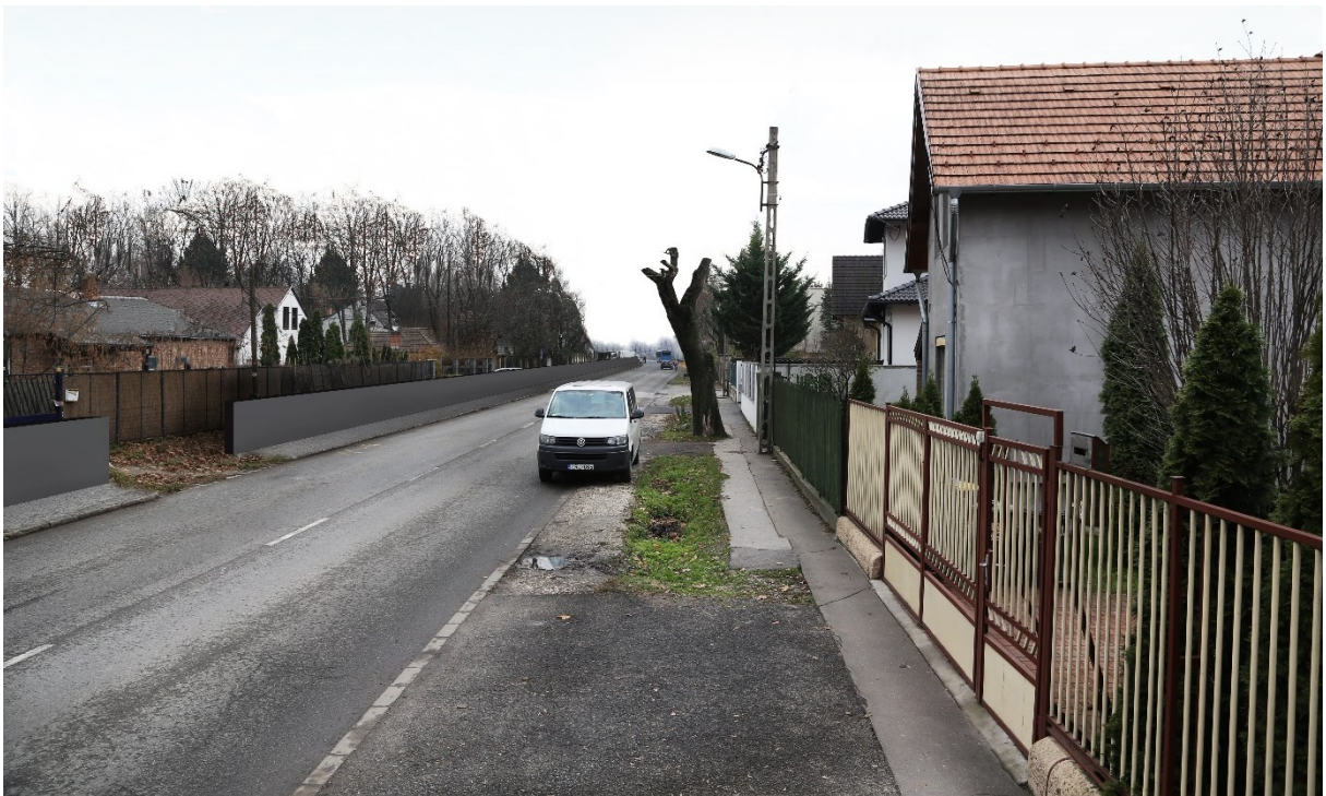
7. 5. fejezet 5. kép Vasbeton árvízvédelmi fal kialakítása a mértékadó árvízvédelmi szintig kulisszanyílóval
