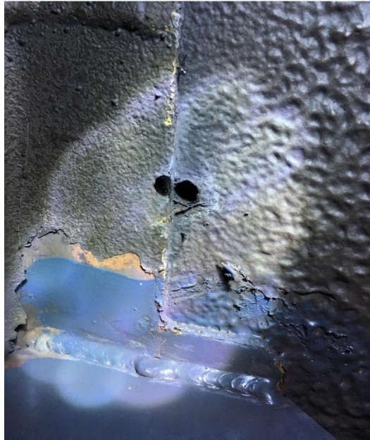
54. ábra: Reflektorfényben a felületvédelem, a hegesztés és az esőelvezető furat, 2020.07.10-én
