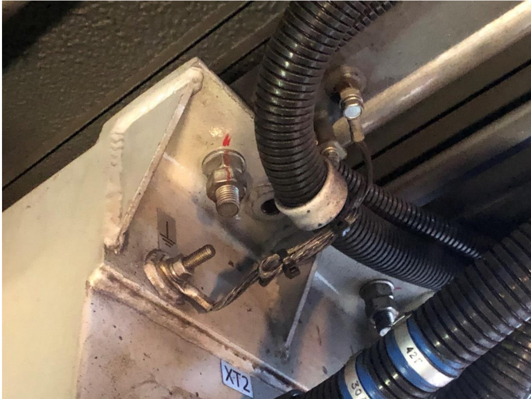
27. ábra: Hiányosan és helytelenül alkalmazott csavarkötés nyomaték jelölés
