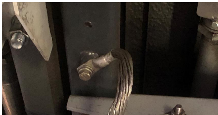
37. ábra: „U” alakú tartó funkció nélküli furattal ellátva
