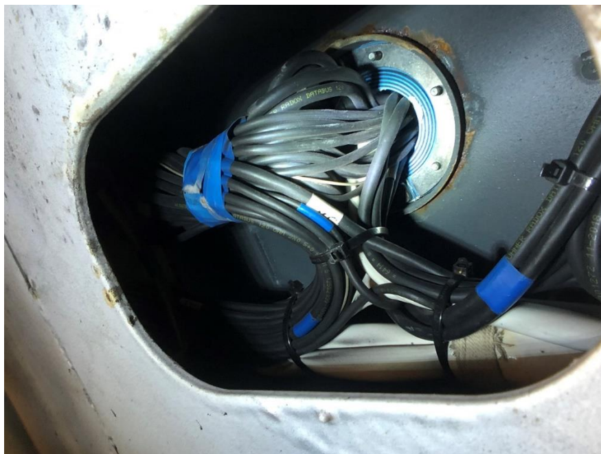
40. ábra: Kábelköteg hanyag vezetése fokozza
