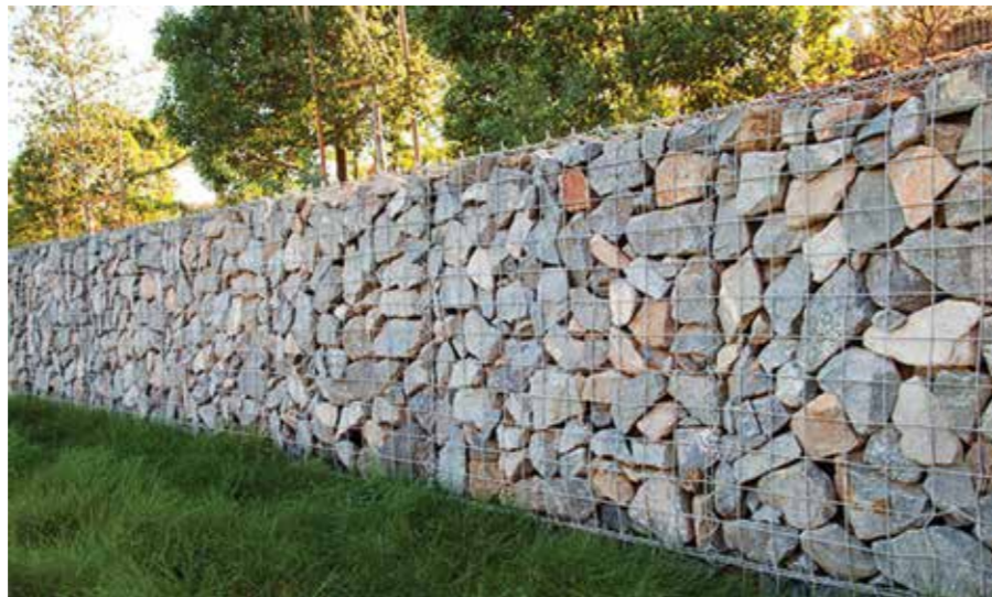
Példa a gabionfalas partfal kialakításra
