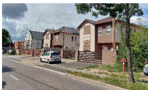
Folyamatban lévő építkezések (2022)
