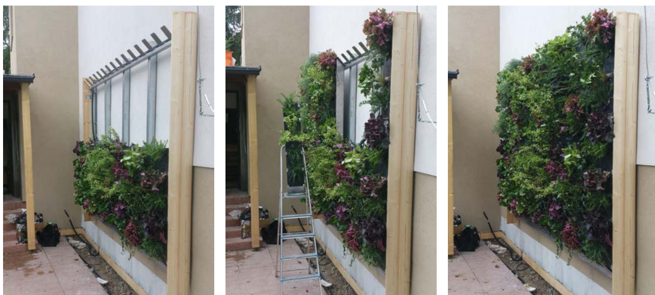
114–116. ábra Kazettás rendszerű zöldhomlokzat megvalósítás közbeni és végleges képei (Bimbó utcai Óvoda, Szentendre)
