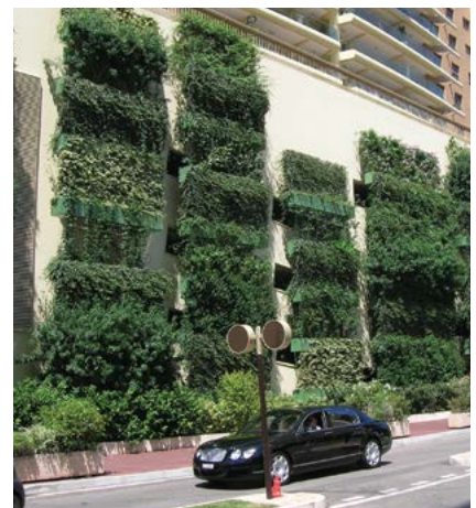
69. ábra Felület jellegű támszerkezetre futtatott kúszónövények parkolóház esetén (Monaco)
