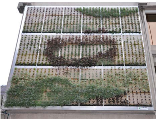
158–160. ábra Független gyökérszónás zöldhomlokzat beültetési képe és a növények fejlődése a begyökeresedési időszakban
