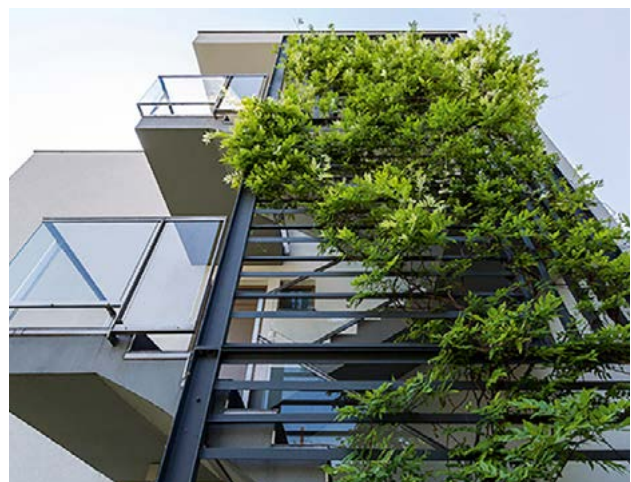
164. ábra Vízszintes osztású merev acél támszerkezetre futtatott lilaakác ( Wisteria sp. )
