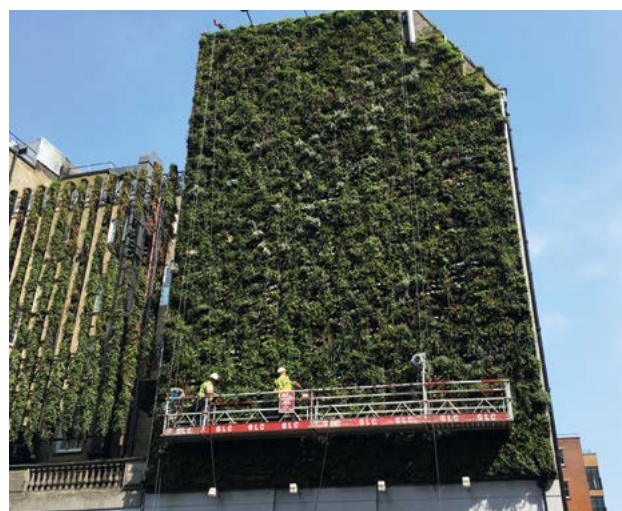
210–213. ábra Zöldhomlokzat karbantartása létrás, emelőkosaras, alpintechnikus és függesztett hidas megközelítéssel (két bécsi, budapesti és londoni épület esetén)
