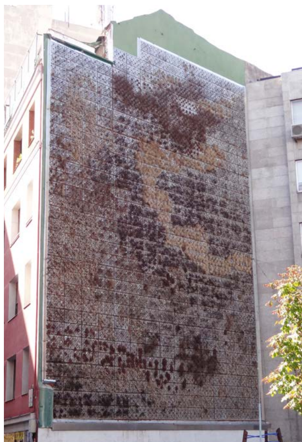
224–226. ábra Üzemeltetés hiánya a zöldfal visszafordíthatatlan tönkremenetelét okozhatja
