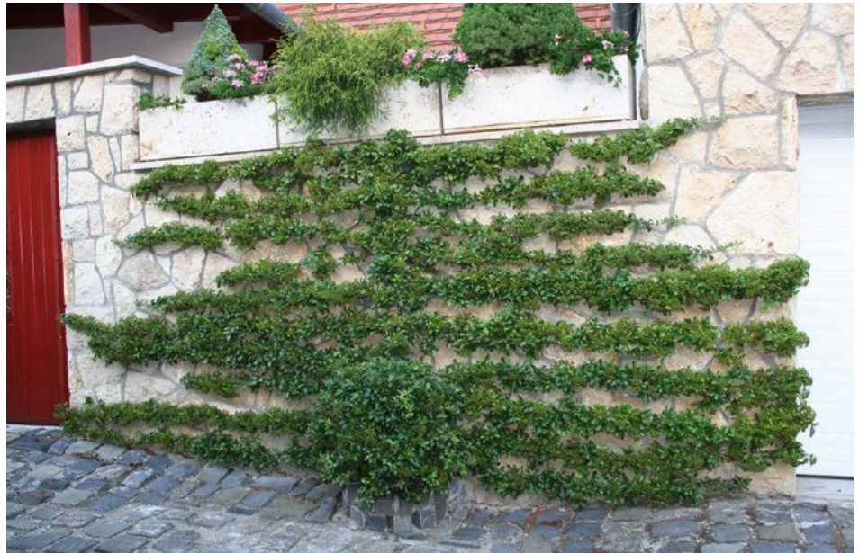
83. ábra Alakfa támfalkerítésnél
