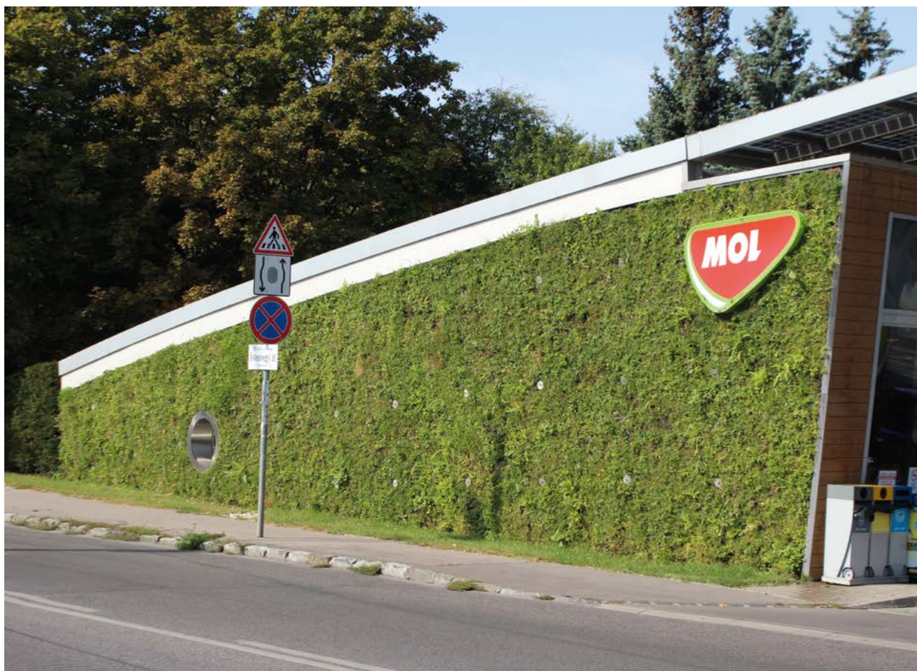
256. ábra Dombház érzetét kelti a növényzettel borított homlokzat
