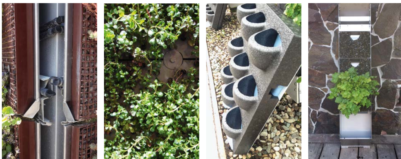
110–113. ábra Az egyes rendszerek különböző kialakítású, anyagú és megjelenésű kazettái
