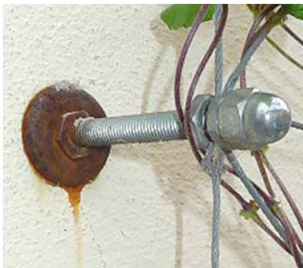
232. ábra Eleinte esztétikai, majd statikai gondot is okozhat egy nem megfelelően időjárásálló elem alkalmazása
