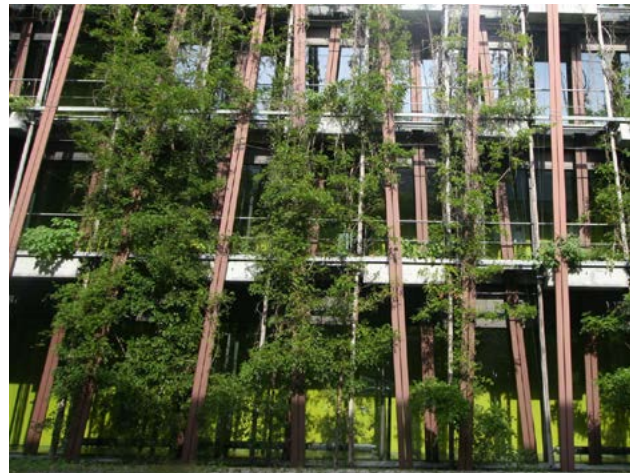
74. ábra Többféle taxonnal befuttatott állványrendszeres megoldás (Adlershof Institut für Physik, Berlin TU)
