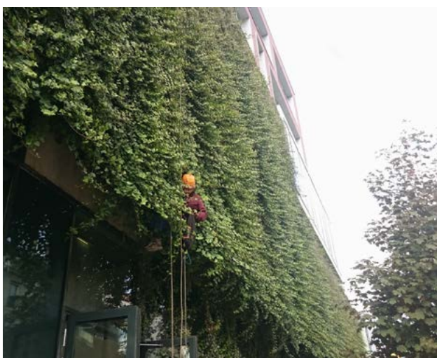
210–213. ábra Zöldhomlokzat karbantartása létrás, emelőkosaras, alpintechnikus és függesztett hidas megközelítéssel (két bécsi, budapesti és londoni épület esetén)
