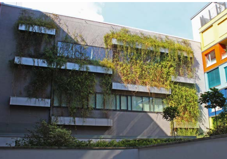
47–48. ábra Kúszónövények eredhetnek az épület homlokzatán elhelyezett planténerben (Simplon Udvar – Budapest, lakóépület – Bécs)
