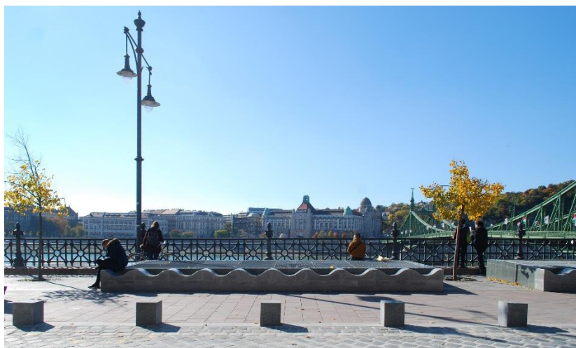
A közműberendezések, gépészeti részletek is a térrendszer részeként jelennek meg – a pad bevilágítót, szellőzőt rejt magában
