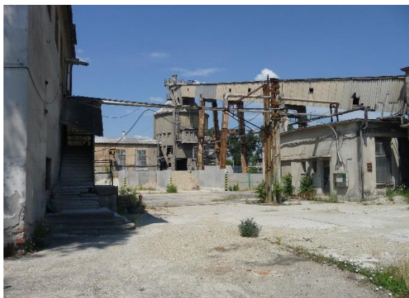
XI. kerület, Kelenföld, betonelem gyár
