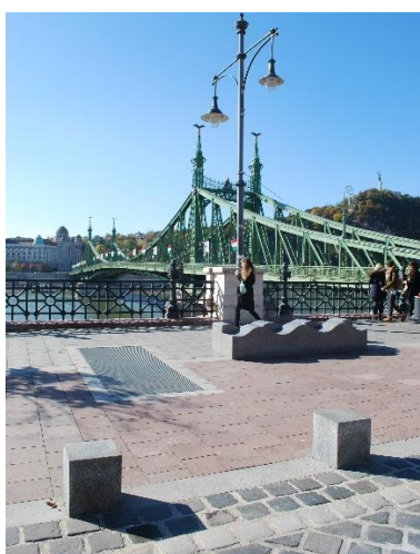
A közműberendezések, gépészeti részletek is a térrendszer részeként jelennek meg – a pad bevilágítót, szellőzőt rejt magában
