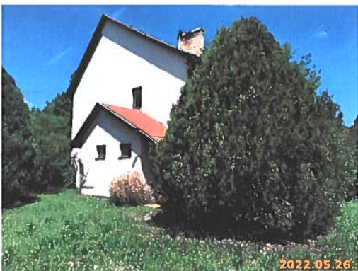
déli udvari homlokzat
