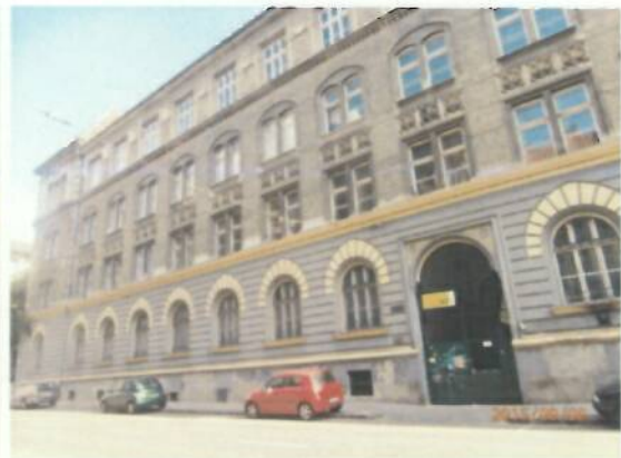
Szondi utcai homlokzat
