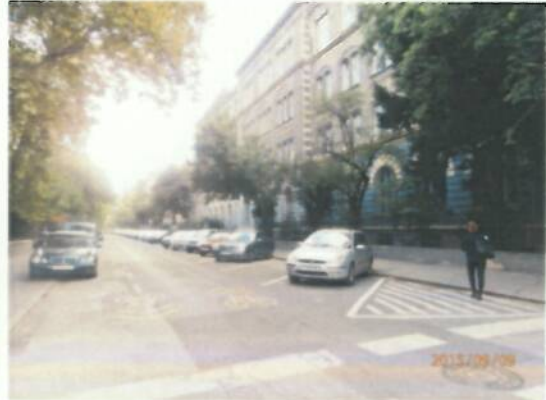
Rippl-Rónai utcai homlokzat
