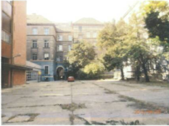
Udvar a kazánház felől
