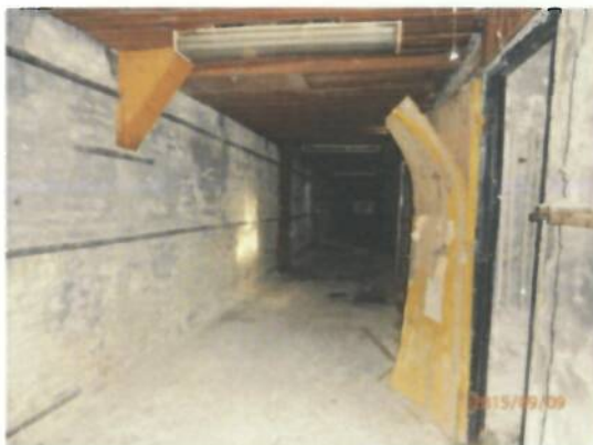
Talajnedvesedés nyomai láthatók a padozaton és a falakon
