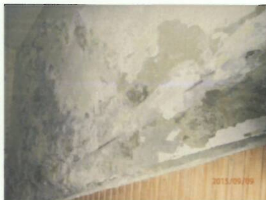
Talajnedvesedés nyomai láthatók a padozaton és a falakon
