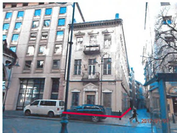
Értékelt ingatlan homlokzata a Kecskeméti utca felől
