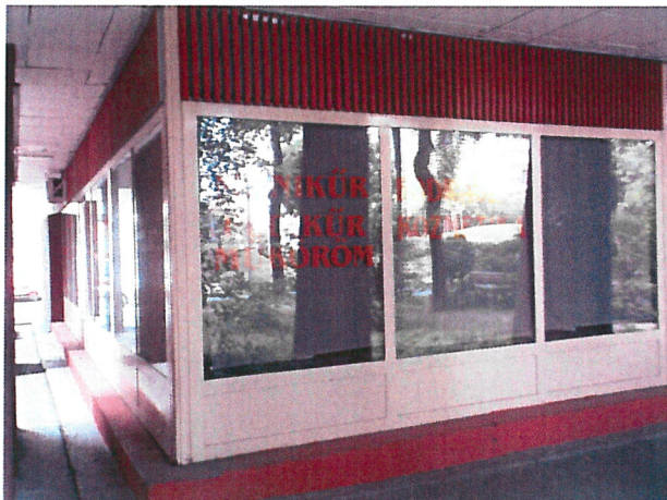
oldalhomlokzat felőli nézet
